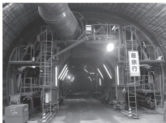
写真—1 セントル全景
