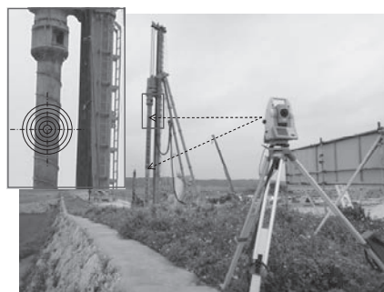
写真-1 計測状況（先行削孔用のケーシング対象）
