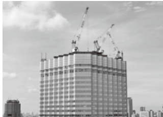
写真一 4 仮設クレーン
