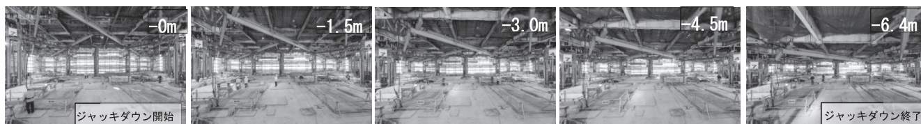
写真-8 ジャッキダウン実施状況 (内観)
