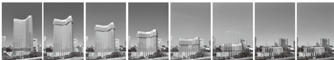
写真-9 ジャッキダウン実施状況 (外観)
