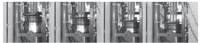
⑤50mm 降下・確認 → ⑥100mm 降下・確認 → ⑦150mm 降下・確認 → ⑧定着モードで降下
