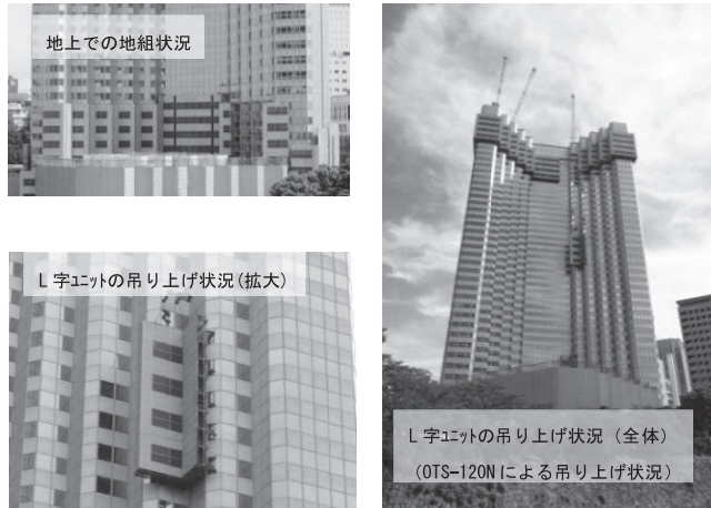
写真一 5 足場工事
