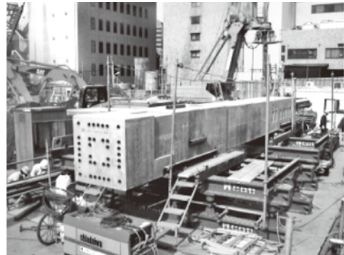
写真一 1 HSPC 構真柱の地組み写真
