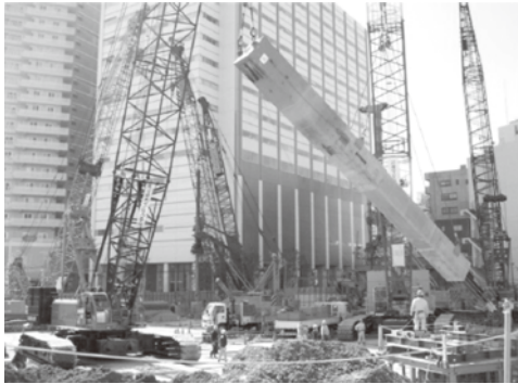
写真-2 HSPC 構真柱の建て起し状況
