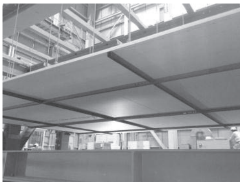
写真一 3 試験体全景 (天井仕上げ面側)
