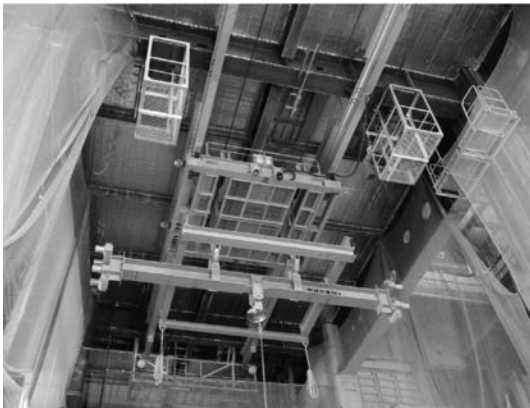
写真-1 25t吊テルハ (トローリ他全景)
