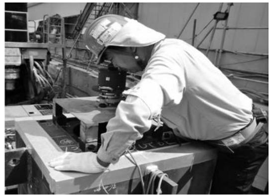
写真-7 鉛直計による構真柱建込み制度管理状況
