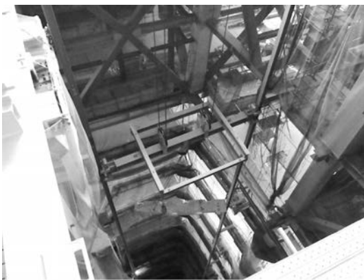
写真-2 25t吊テルハ (揚重時)
