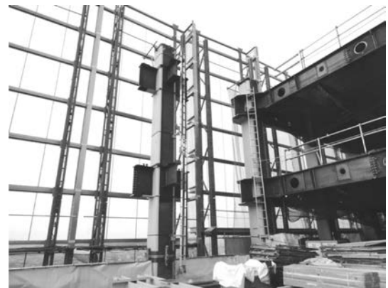
写真-4 スライドカバー (鉄骨建方中)
