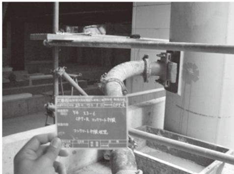
写真一6 1階コンクリート圧入状況 (STEP5)
