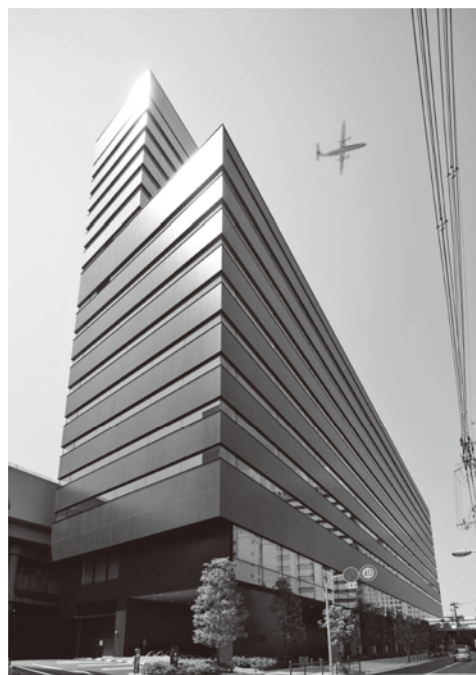
写真—1 建物外観
