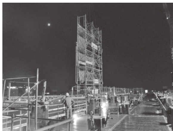
写真—12 外部足場ブロック化施工状況（夜間作業）
