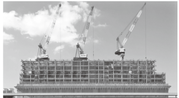
写真一8 鉄骨建方状況 (南面)
