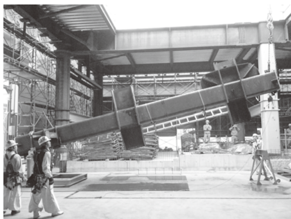
写真—11 仮設開口での柱建方状況
