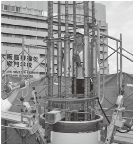
写真一4 内蔵鉄筋接合状況 (STEP2)
