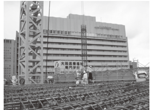
写真-3 内蔵鉄筋柱設置状況 (8Fより) (STEP2)
