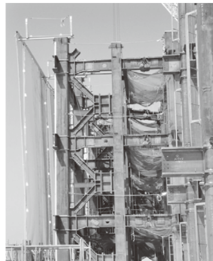
写真一9 先行ネット設置状況
