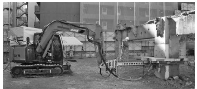
写真一六 柱切断状況
