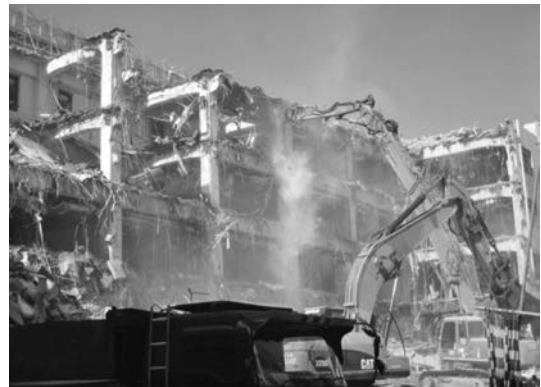
写真1 従来の破断・粉砕解体工法
