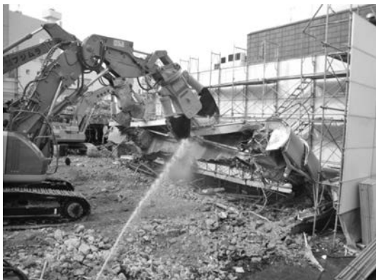
写真—2 大型破碎機による柱・大梁部材の引き倒し状況
