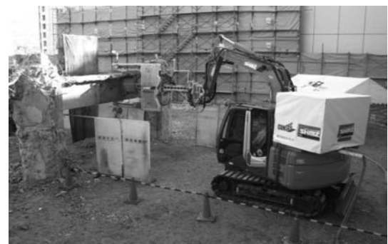
写真一七 大梁切断状況
