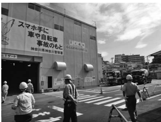
写真二 工事現場と周囲の住宅
