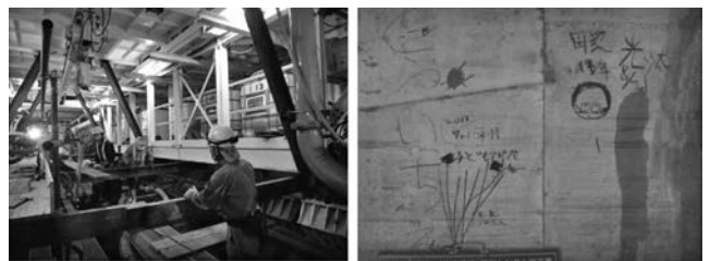
写真五 インバート施工
