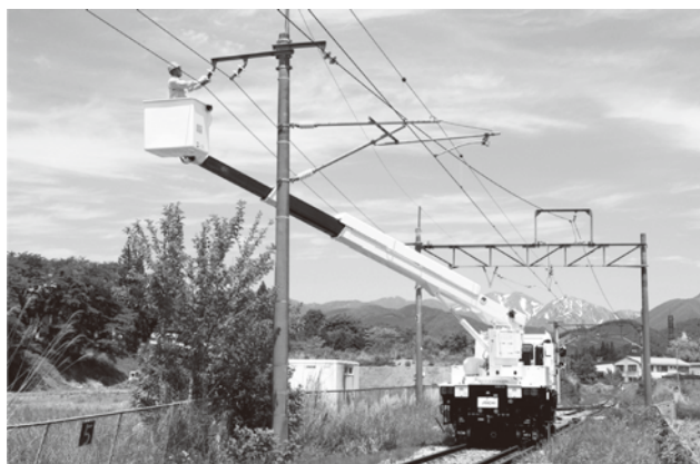
写真—8 アイチコーポレーション LK17KFE 軌陸両用高所作業車
