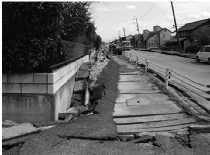
写真二 地下埋設物の浮き上がり
