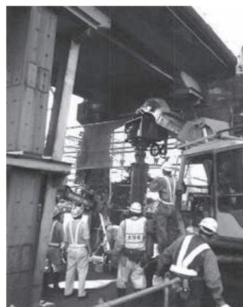
写真-2 油圧式リーダーレス型基礎機械による施工状況
