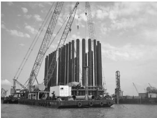
写真一 3 4基のクレーンバージによる上杭の水上新工
