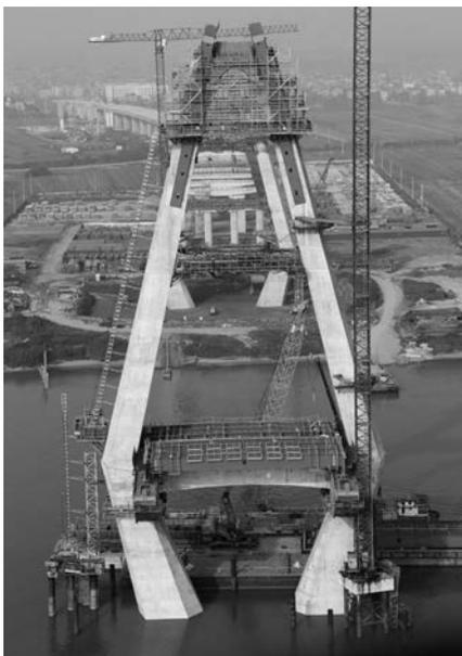
写真-11 タイムシェアによる主塔と上部工の並行作業 (P15)
