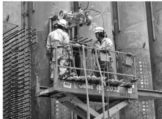
写真一9 日本式多連自動溶接機による鉄筋スタッド溶接
