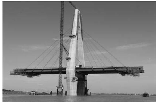
写真-12 主塔完成後、上部工の鋼桁架設が急ピッチで進む
