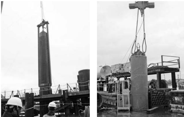
写真一 4 衝撃載荷試験 (PDA) による支持力確認と 23t 重錘
