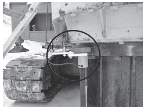
写真-2 回転計の設置状況
