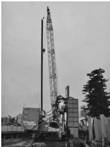
写真—4 造成芯材建込状況
