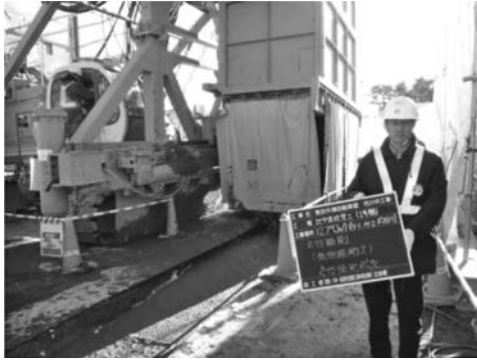
写真—3 先行掘削状況
