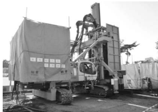
写真-1 本工法施工機
