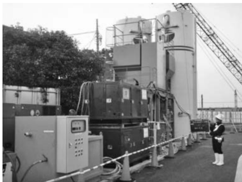
写真一2 プラント設置状況
