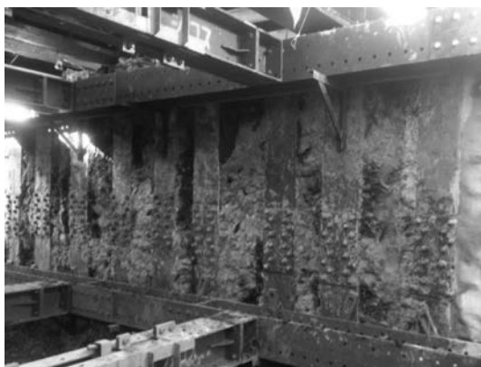
写真-6 施工出来型
