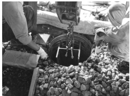
写真-5 芯材建て込み完了
