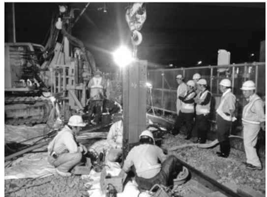
写真-4 芯材建て込み状況
