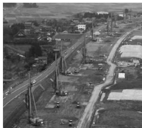
写真—3 施工状況（町軽井地区）
