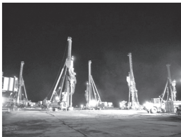
写真—4 夜間施工状況（仙台空港）
