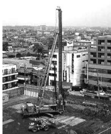
写真—1 本工法による市街地施工状況
