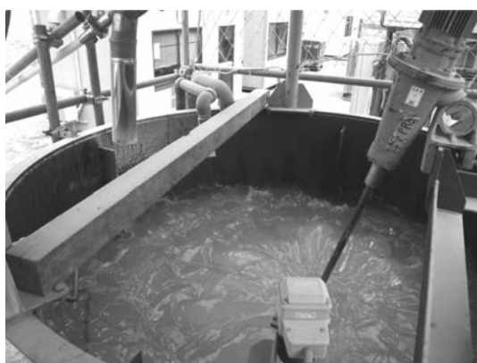
写真-2 分離防止剤プラント
