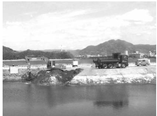
写真—7 バックホウ投入（水深5m以浅）
