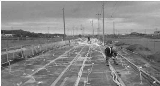
写真一六 施工状況 (注入作業)
