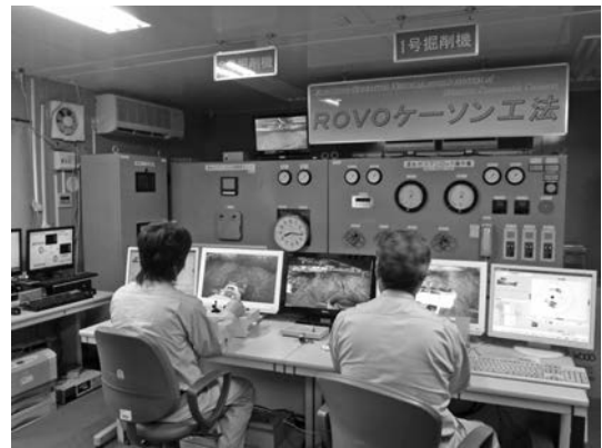
写真-4 遠隔操作状況
