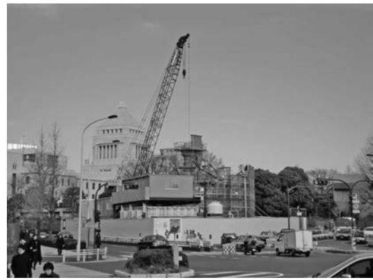
写真一 仮設備配置状況
