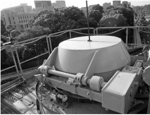
写真—9 ワイヤボックス消音装置（音イーター）
