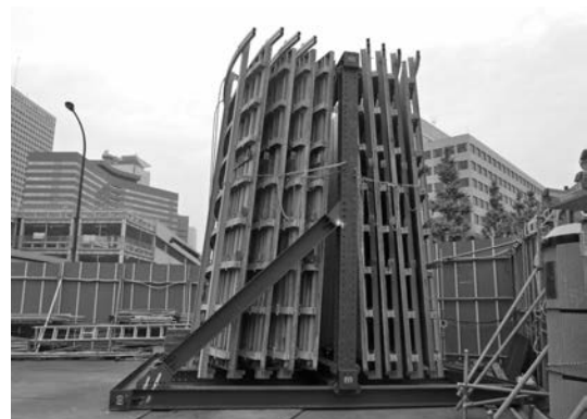
写真一 3 型枠ストックゲージ
