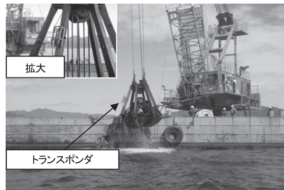
図-3 施工状況写真
