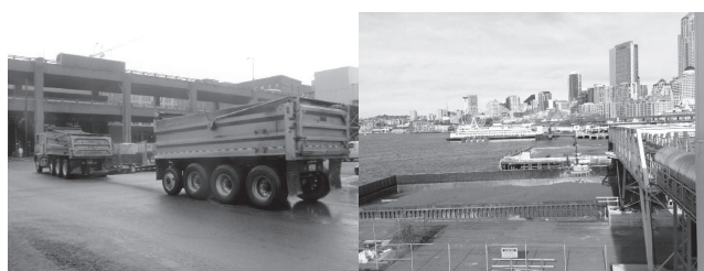
ダンプ搬送 バージ搬送 写真—7 ズリ搬送状況
