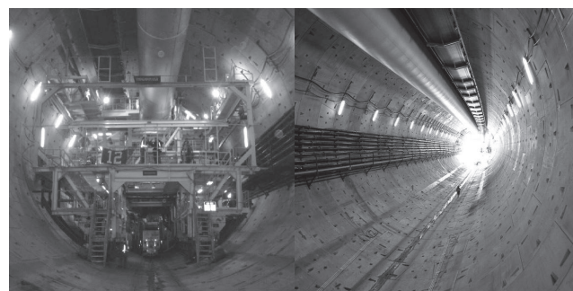
写真—10 坑内状況
