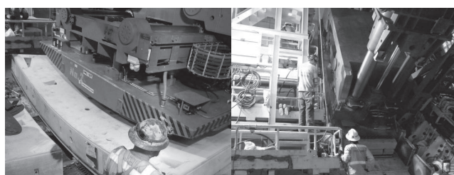
写真—8 セグメント組立状況
