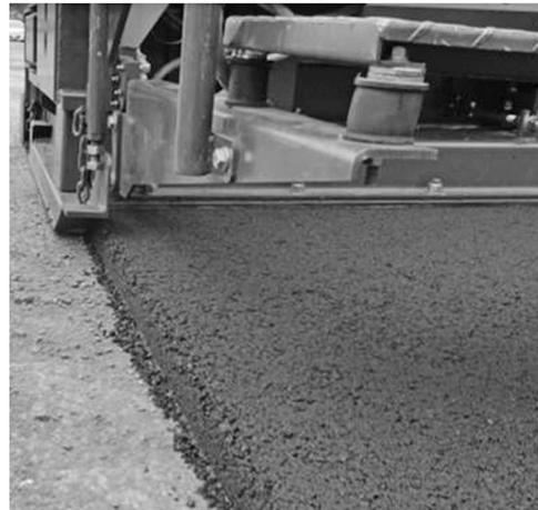
写真-3 サイドプレートによる端部の成形
