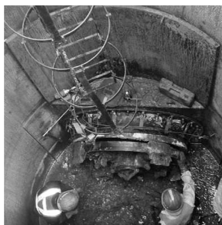
写真-1 DUCMM 工法を用いた推進機の到達完了状況
