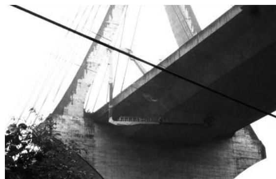
写真-2 橋梁点検車を用いた点検の様子
