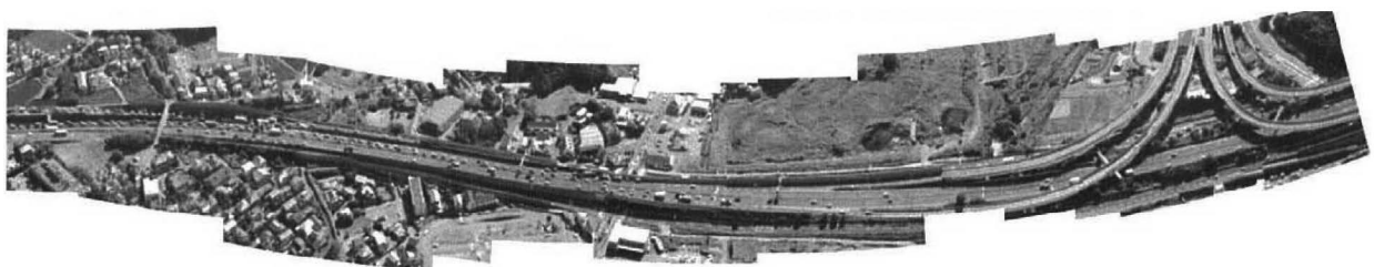
写真一4 つなぎ合わせた空撮画像
