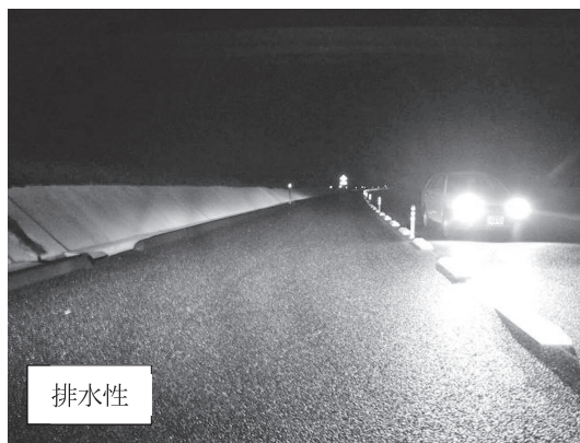
写真—8 夜間視認性 (排水性舗装)
