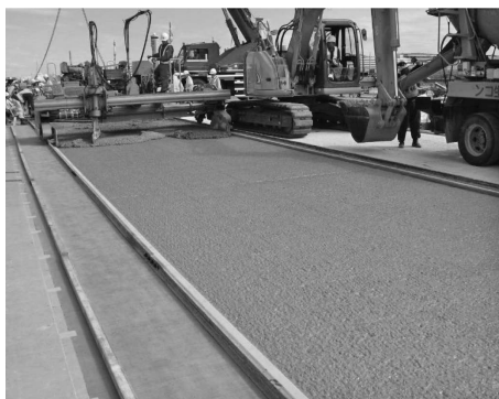
写真—8 大規模施工現場コンクリート打設状況
