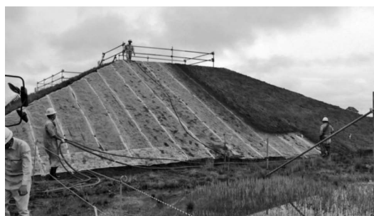
写真-10 緑化工事の様子
