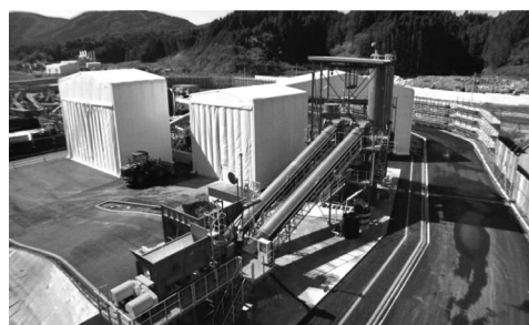
写真-1 造粒固化処理施設
