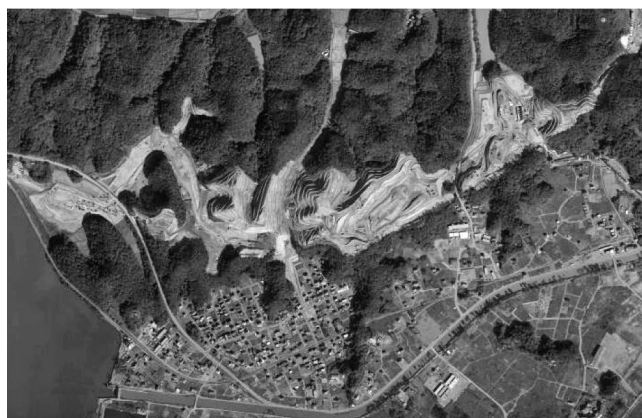
写真ー3 東松島市野蒜地区の造成状況
