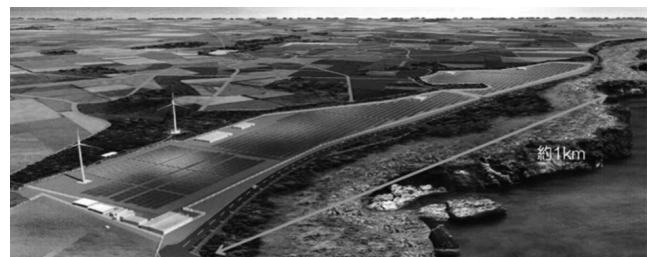
図—10 メガソーラー実証研究設備（出典：沖縄電力ホームページ）
