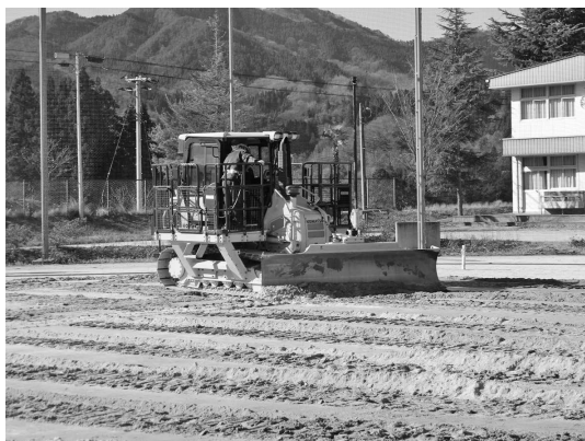
写真—11 福島県伊達市で行った ICT 施工の実証実験の様子
