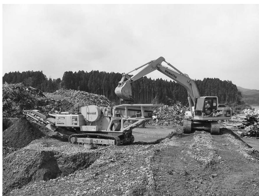
写真—4 宮城県南三陸町でのがれき処理
