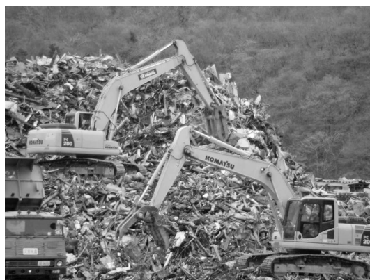
写真—2 宮城県女川町でがれき処理を行う建設機械
