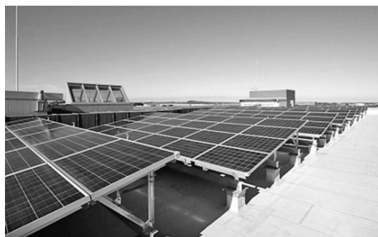
写真—14 太陽光パネルを搭載した栗津工場の建屋
