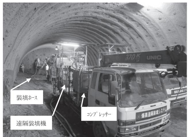
写真-2 爆薬遠隔装填システム使用状況
