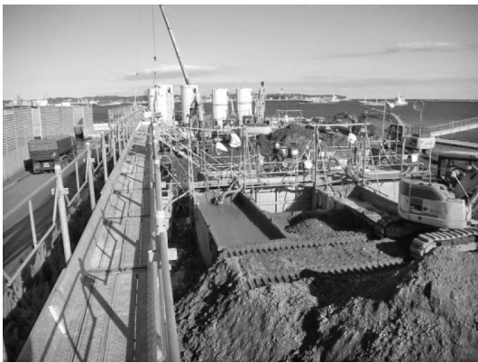
写真一〇 プラント全景
