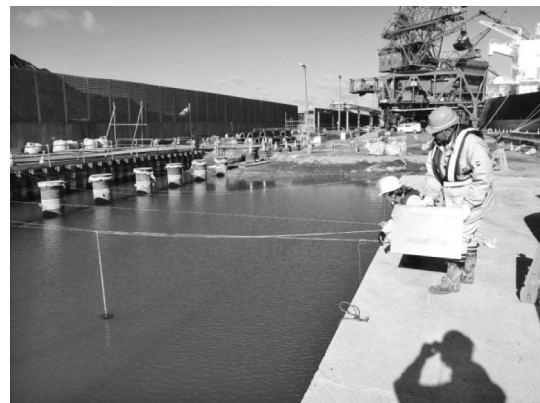
写真一 7 層厚管理状況
