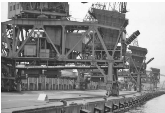
写真-1 被災した 7 号ふ頭岸壁 (7-2)
