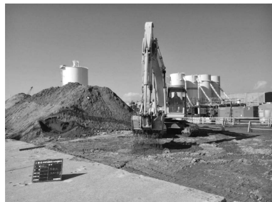
写真一 8 ロータリー式スケルトンバケットによる事前ふるい分け状況
