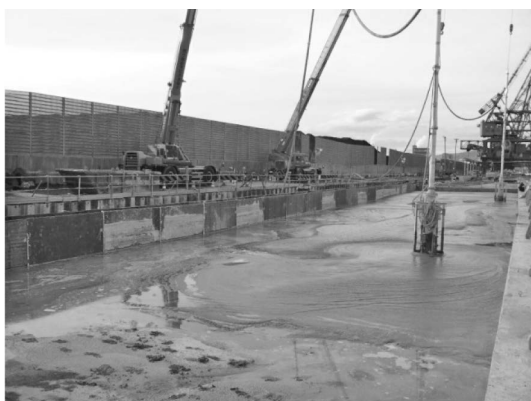
写真一 6 トレミー管による打設状況
