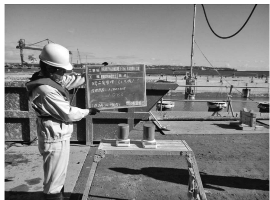
写真一3 筒先での処理土の密度確認
