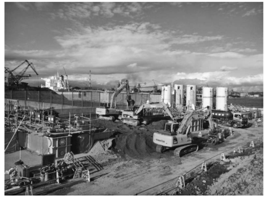
写真一〇 プラント全景
