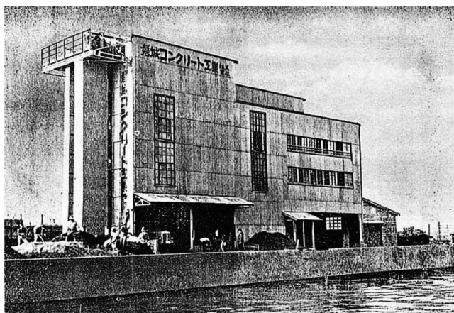
写真—6 日本初の生コン工場誕生「東京都業平橋につくった東京コンクリート工業」
