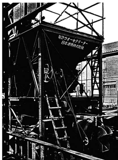
写真一5 「ウォーセクリーターの活躍」
