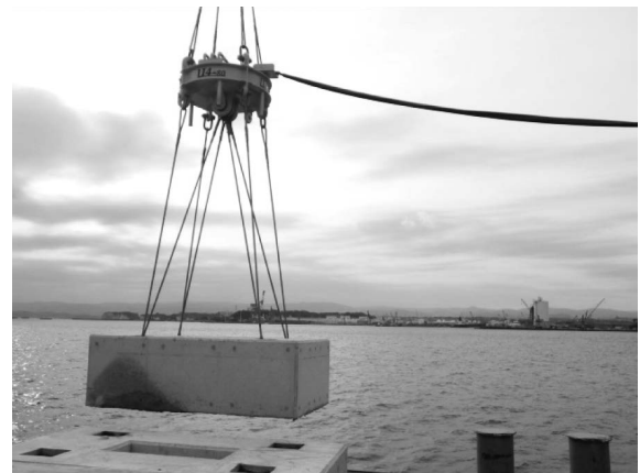
写真二 施工状況
