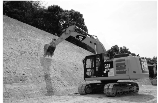
写真-2 マシンガイダンスによる施工状況
