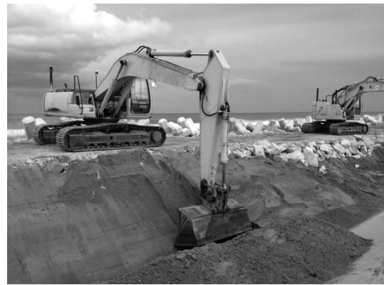
写真－3 築堤工事での導入例
