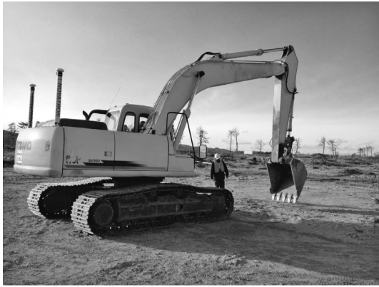
写真—7 システム設置状況 (1.25 m 3 クラス)
