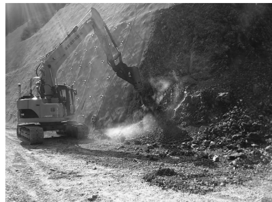
写真－4 切土施工での導入例（ブレイカー使用）
