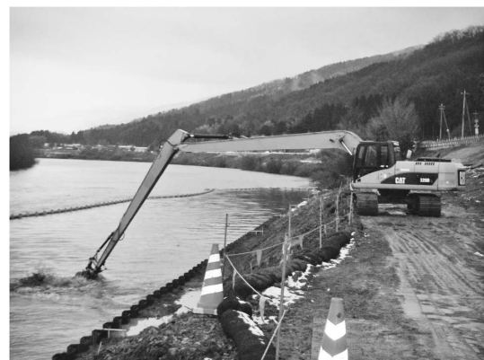
写真－5 河床掘削での導入例
