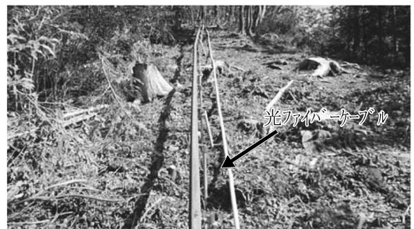
写真-4 光ファイバケーブル敷設状況
