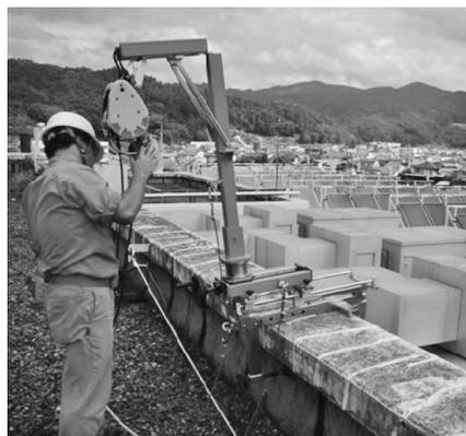
写真—6 ウィンチの取付け
