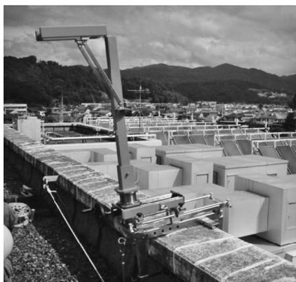
写真—5 吊りアーム支柱の取付け
