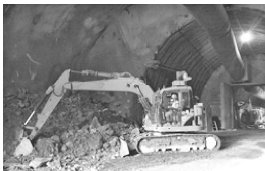
写真—1 狭いトンネル現場でのシステム稼働状況
