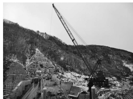
写真-5 コンクリート打設状況
