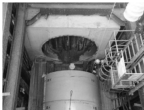
写真一 3 FRP 製矢板工法を用いた推進工事での発進前状況
