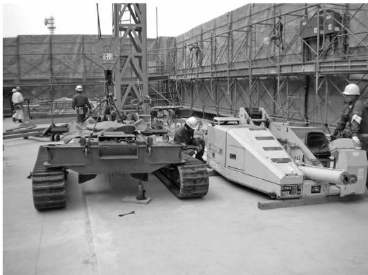
写真-3 組立式クローラークレーン
