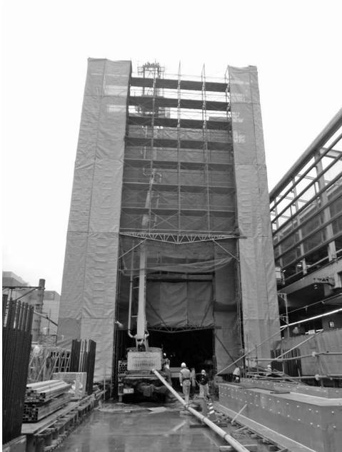
写真-6 中継ポンプ車による打設状況
