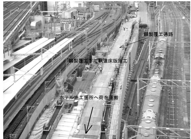
写真-4 鋼製覆工通路
