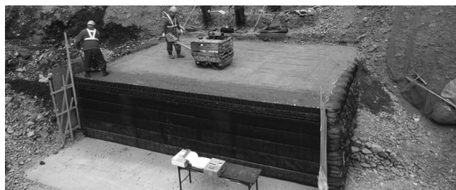
写真一3 転圧状況
