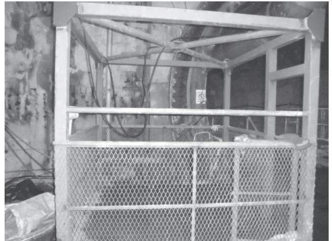
写真—5 マンケージ（立坑内作業員搬送用ゴンドラ）
