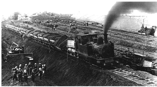
写真—26 カスリーン台風利根川決壊復旧工事
