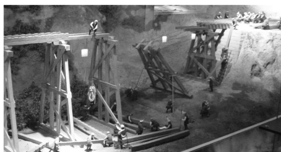
写真一 7 橋脚建込 (小樽総合博物館ジオラマ)
