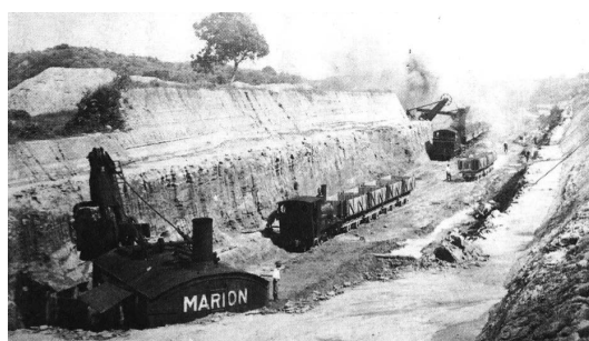
写真—21 嘉南大圳の水路掘削
