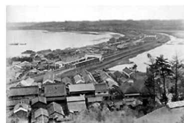
写真一 6 品川沖の築堤敷設
