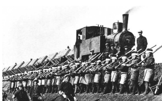
写真-14 利根川改修の女土工
