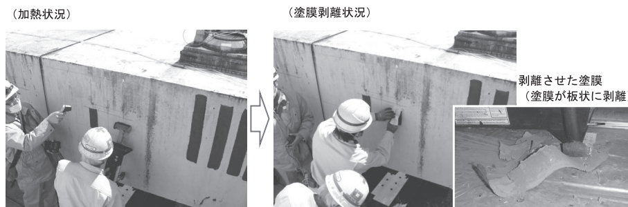
写真一2 塗膜除去試験状況
