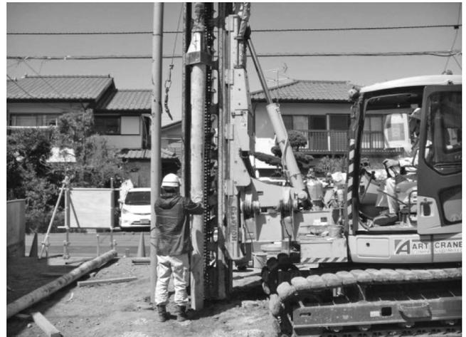
写真-1 丸太の打設状況
