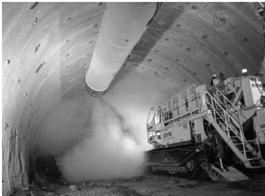
写真—4 実掘削時の粉じん封じ込め状況
