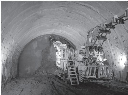
写真一1 大型自由断面掘削機による掘削状況
