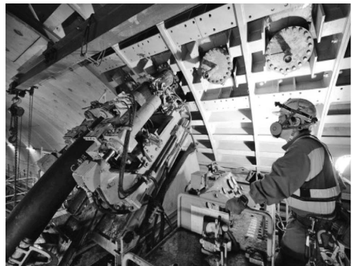
写真一1 曲線パイプルーフ施工状況
