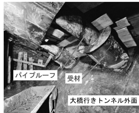
写真-3 パイプルーフ到達側固定状況
