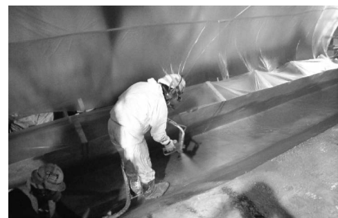
写真-6 Uターン路ウレタン吹付防水施工状況
