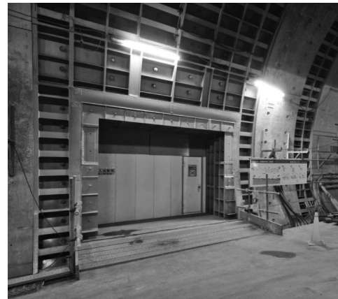
写真一9 横連絡坑全景
