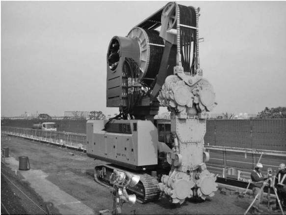
写真—3 本工法マシン組立完了状況
